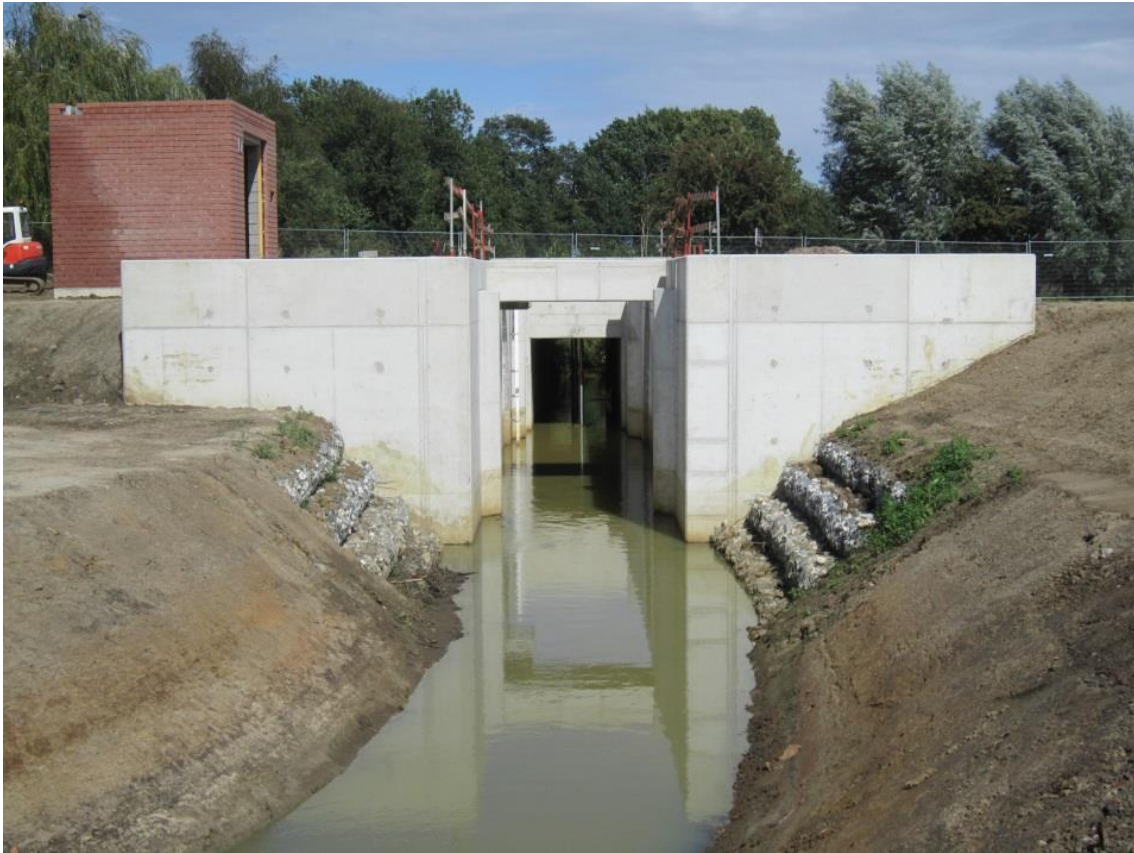
Foto: stuw op Begijnenbeek thv Zandstraat in Assent
