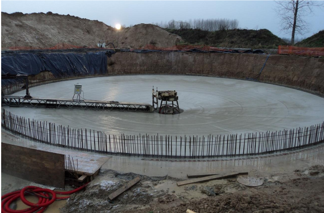
Foto: RWZI Jesseren in aanbouw (foto Aquafin)
