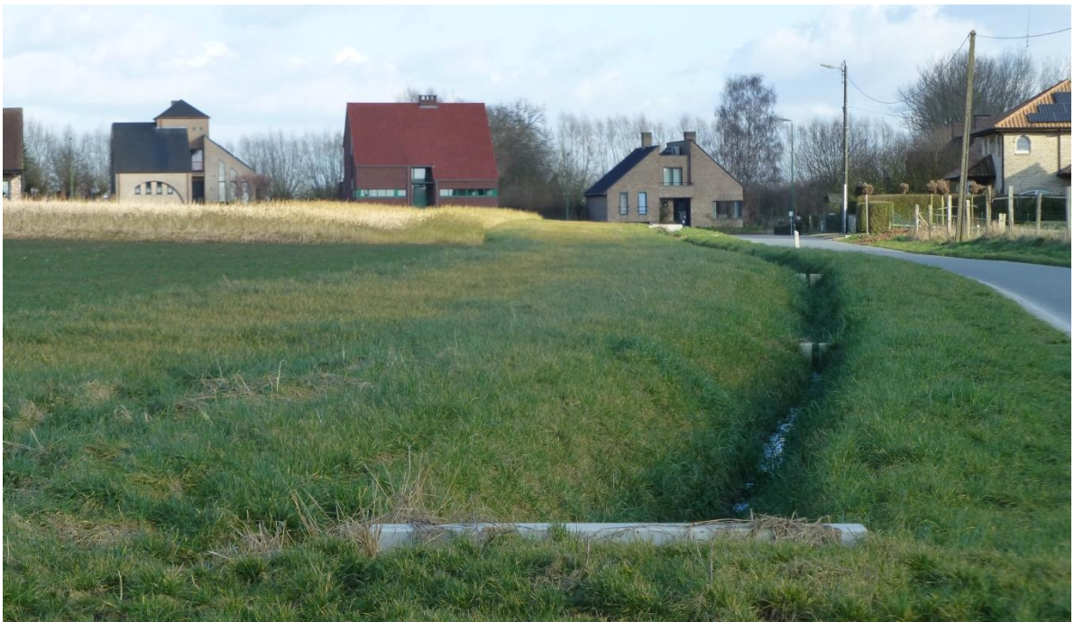
Figuur 7: Aanleg erosiebestrijdingsmaatregele te Galmaarden, grasbufferstroken
