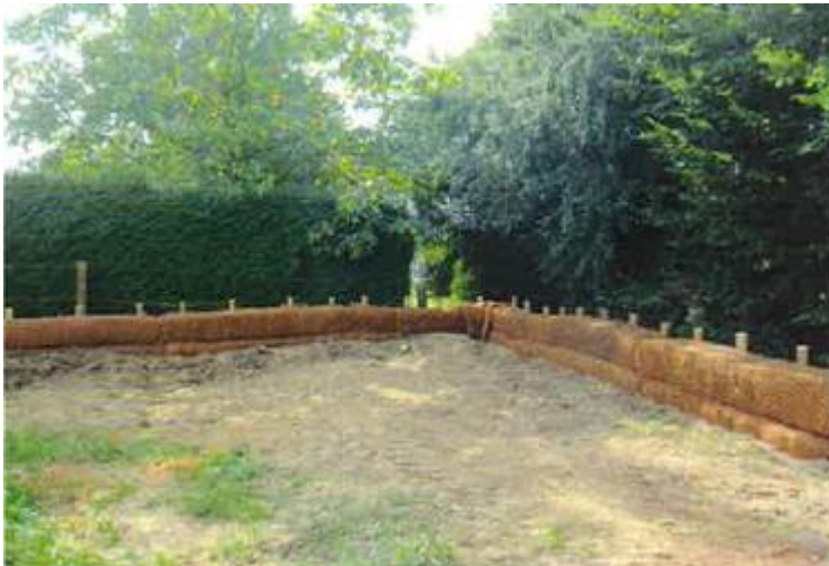
Figuur 6: Aanleg erosiebestrijdingsmaatregel te Moerbeke, Geraardsbergen: kokosbalendam
