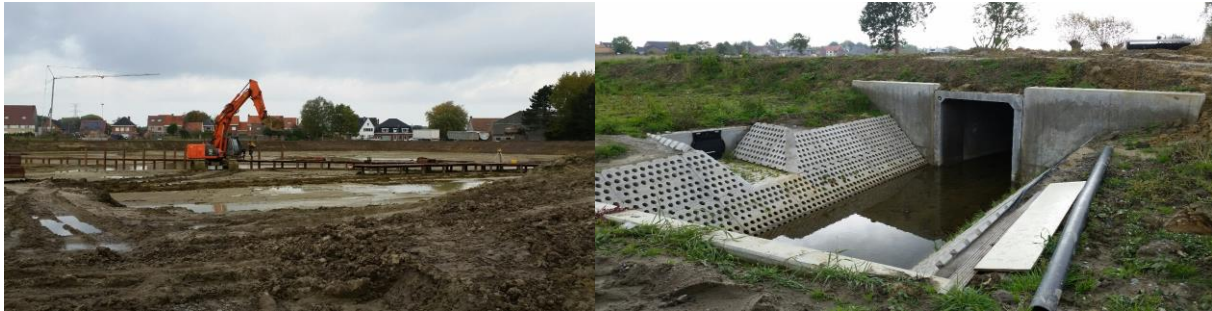
Figuur 27: aanleg van het bufferbekken op de Plaatsbeek (oktober 2016, ©Bekkensecretariaat)
