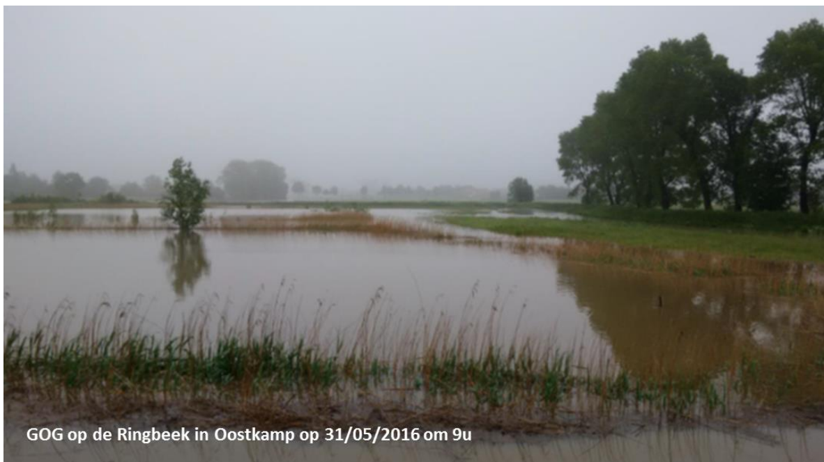
Figuur 17: Gecontroleerd overstromingsgebied op de Ringbeek te Oostkamp in werking tijdens de hevige neerslag van 31 mei 2016 (©Provincie West-Vlaanderen - Dienst Waterlopen)
