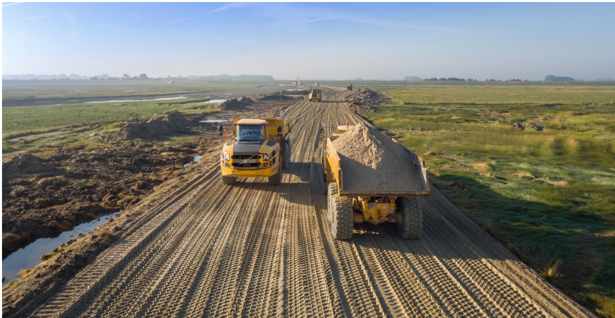
Figuur 22: aanleg nieuwe dijk (© MDK)
