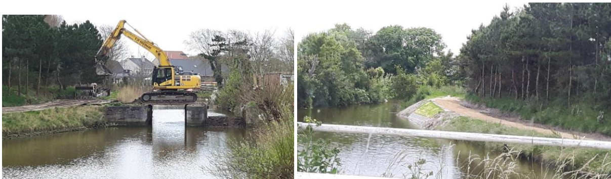
Figuur 19: afbraak oude sluis op de Blankenbergse Vaart (© VMM-AOW)
