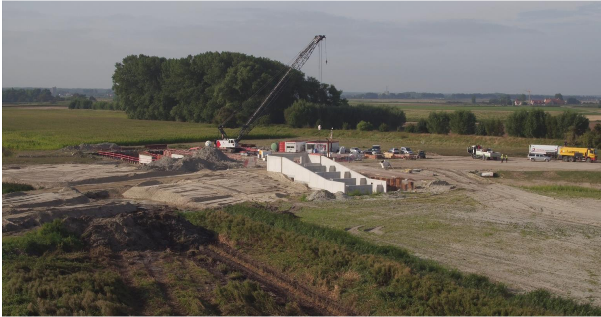
Figuur 23: bouw van het pompstation met visvriendelijke uitwateringsconstructie (© MDK)
