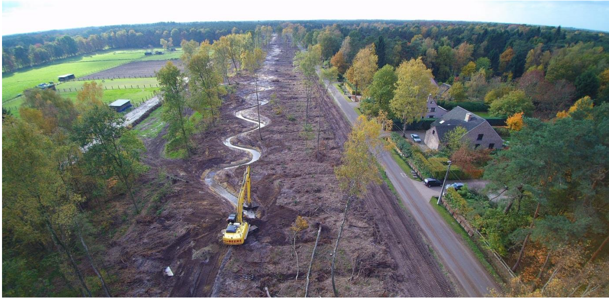
Figuur 22: Aanleg bypass Ritsschotsloop © van Beers Hogeloon
