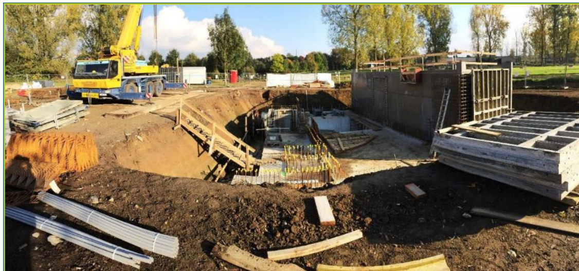
Figuur 15: De werken aan de nieuwe stuw aan de ingang van het wachtbekken van Volsembroek (Sint-Pieters-Leeuw) (©Natuurpunt)
