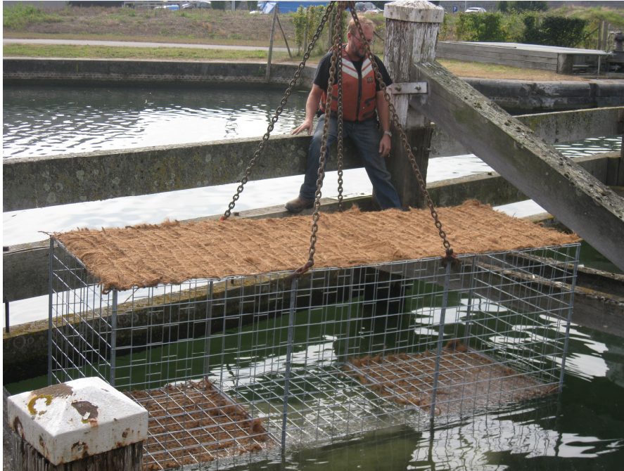
Figuur 20: Aanleg van de schuilplaatsen op het Kanaal Leuven-Dijle (©Provinciaal Visserijfonds Vlaams-Brabant)
