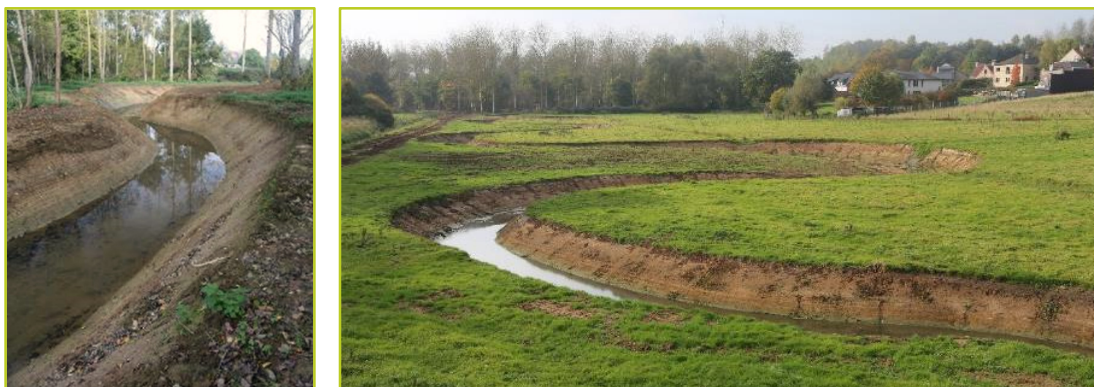
Figuur 13: De nieuwe meanderende loop van de Zuunbeek opwaarts het wachtbekken van Volsembroek (Sint-Pieters-Leeuw)
