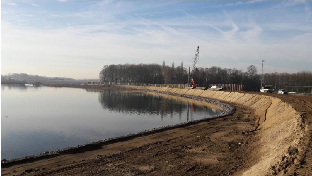
Figuur 16: Sigmaproject Dijlemonding- Deelgebied Grote Vijver: kofferdam in aanbouw (©WenZ)
