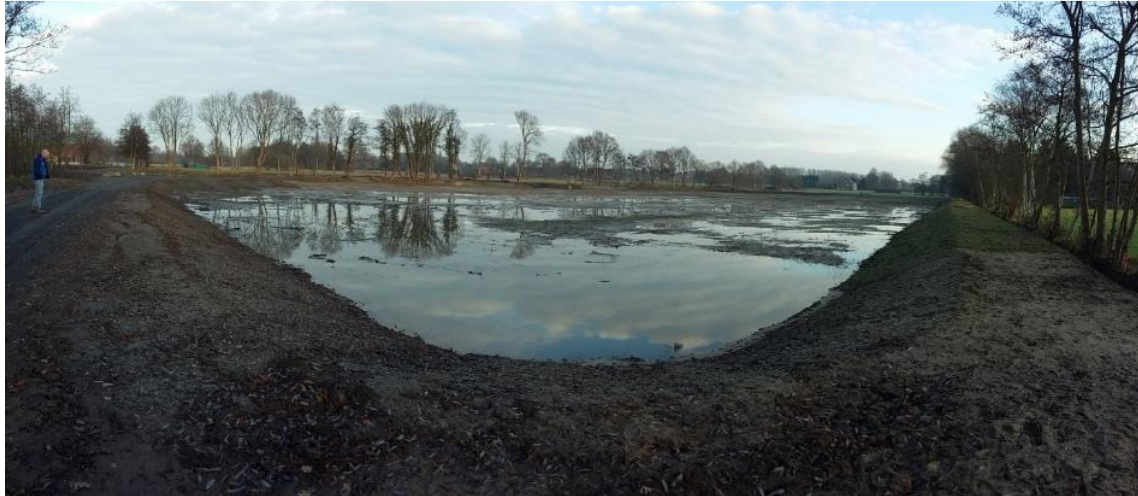
Figuur 19: Het recent aangelegde GOG op de Wolzakkenleibeek in Putte (©Provincie Antwerpen)
