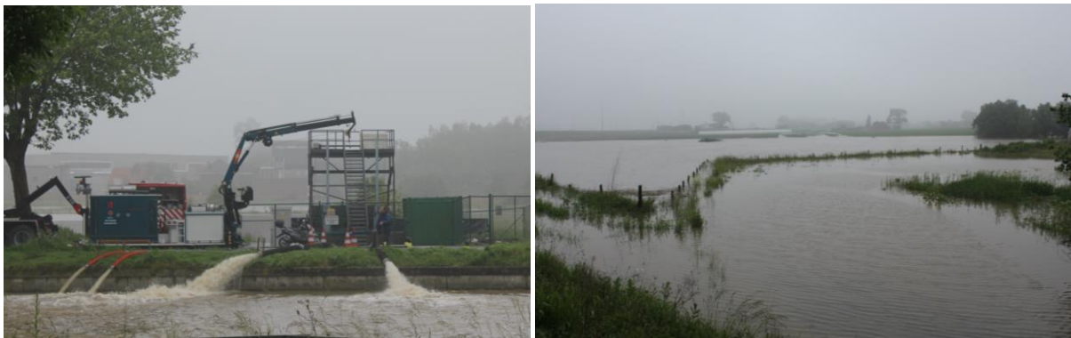
Figuur 14: overstromingen ter hoogte van de syphon van de Babillebeek onder het kanaal Roeselare-Leie en de samenvloeiing van de Mandel en de Roobeek. Het water van de Babillebeek werd door de civiele bescherming overgepompt in Kanaal Roeselare-Leie op 31 mei.
