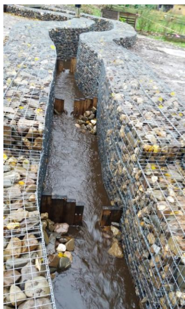
Figuur 10: Vistrap aan de Galdermansmolen op de Itterbeek in Bree
