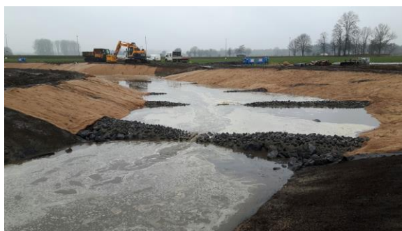
Foto's: vistrap aan de watermolen van Tielen
