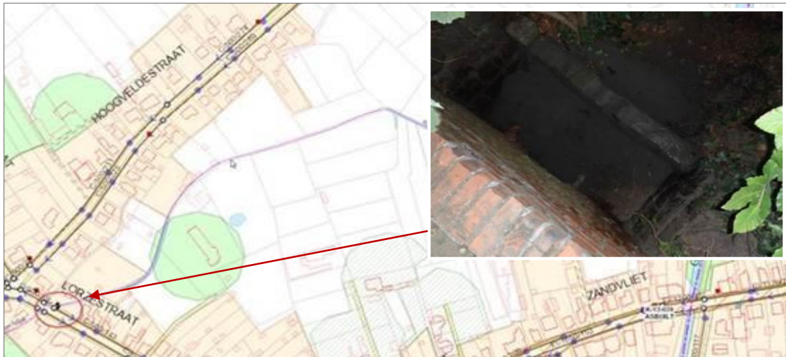
Figuur 4: overstortmuur thv Lorzestraat 90
