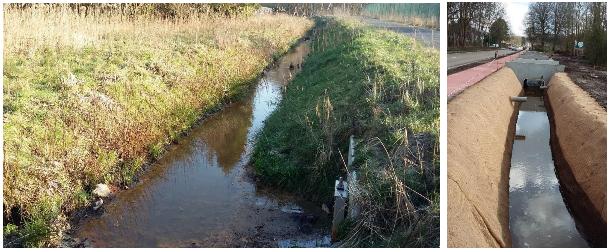
Foto's: nieuwe bedding Burgemeesterloop parallel aan de spoorweg (l) en langs de Gompelbaan (r)
