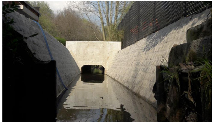
Foto: deels openlegging en nieuwe koker Arkelloop
