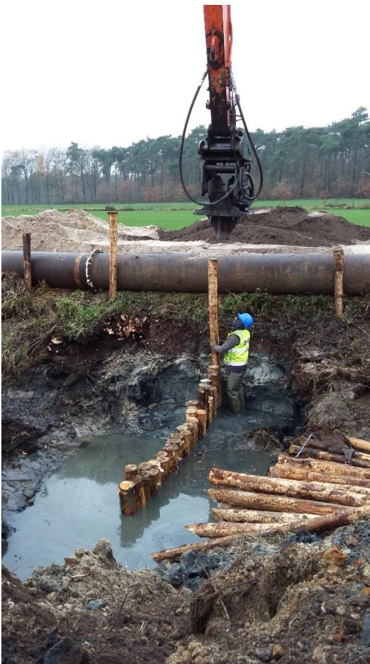
Foto's: aanleg vistrap thv het vismigratieknelpunt 8508-050 op de Wamp (november/december 2017)
