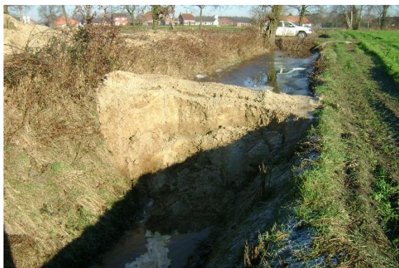
Figuur 9: De vervuiling op een zijloop van het Merkske werd zo snel mogelijk ingedamd.
