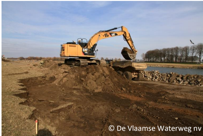
Figuur 20: Weggraven zomerdijk en verwijderen harde oeververdediging in Geistingen (Kinrooi)
