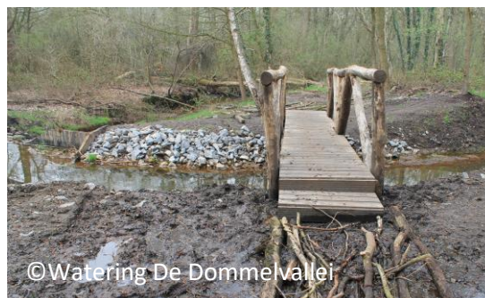
Figuur 15: Nieuwe brug over de Dommel
