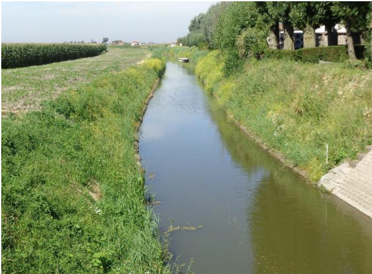
Figuur 14: de Blankenbergse Vaart ter hoogte van het dorp van Meetkerke na uitvoering van de herinrichtingswerken. De taluds begroeiden snel na de werken. © Nieuwe Polder van Blankenberge.
