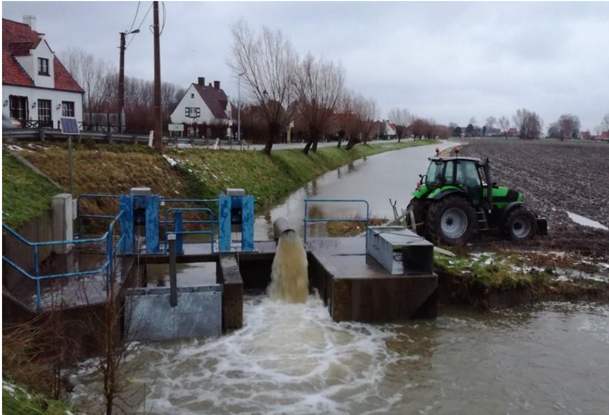
Figuur 6: inzetten mobiele pomp op de Zwinnevaart (© Oostkustpolder, december 2017)
