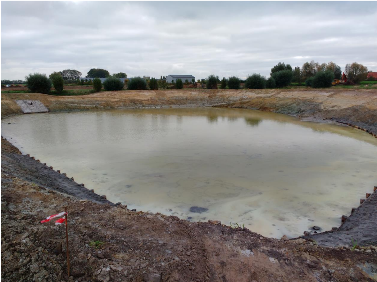
Figuur 9: bufferbekken langs de Ringbeek ter hoogte van de hoeve Braeckeveld (© Provincie West-Vlaanderen - Dienst Waterlopen)
