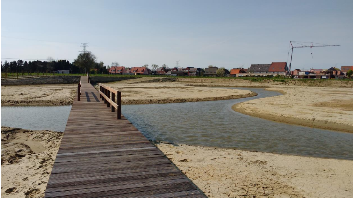
Figuur 17: GOG Plaatsebeek met poel, een vijver en vlonderpaden (© Provincie west-Vlaanderen, Dienst Waterlopen)
