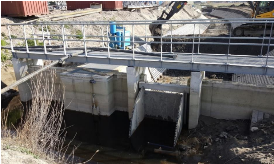
Figuur 20: nieuwe kandelstuw in Zijdelingse Vaart thv Havenrandweg Zuid (© Oostkustpolder)
