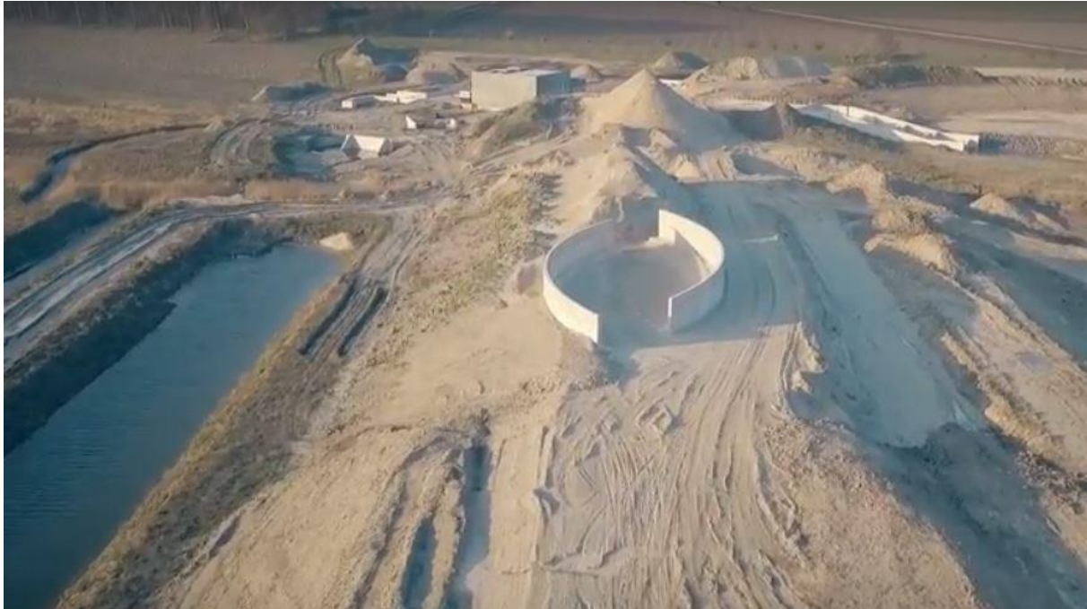
Figuur 15: het pompgebouw en de uitwateringsconstructie (©zwinverandering.eu)
