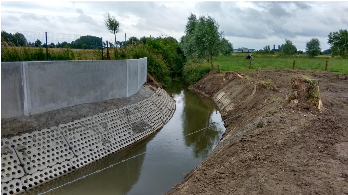
Figuur 8: keermuur langs de Ringbeek ter hoogte van de Ruiseledesteenweg in Wingene (© Provincie West-Vlaanderen - Dienst Waterlopen)
