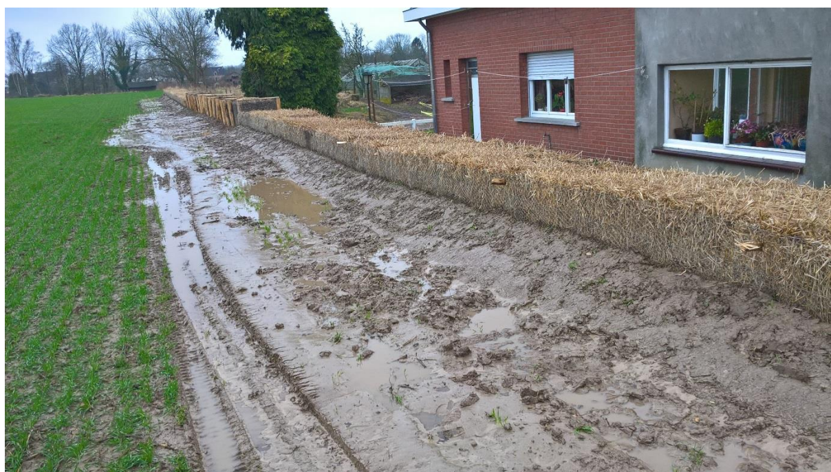
Figuur 6: Houthakseldam en strobaleldam ter hoogte van de Grotstraat in Overijse (©Provincie Vlaams-Brabant)
