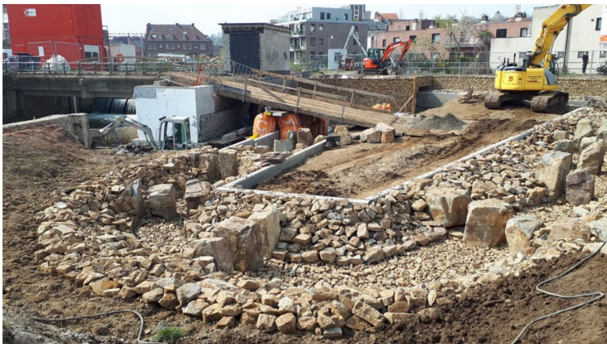
Figuur 16 Werken aan de vistrap langs de Sluismolen op de Dijle in Leuven (© VMM)
