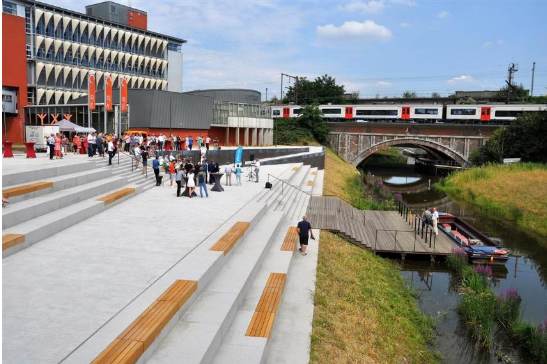
Figuur 14: De heropengelegde Binnendijle aan de Zandpoortvest in Mechelen (©Vlaamse Waterweg)
