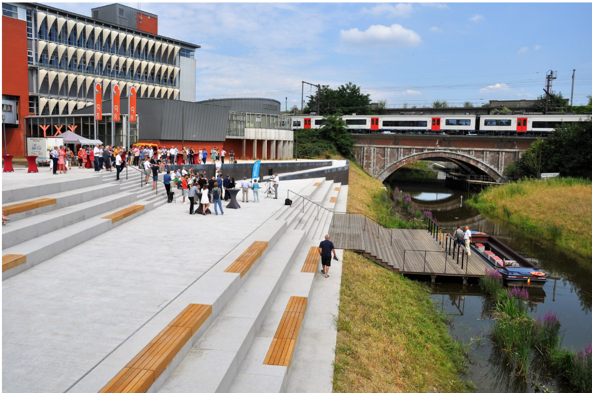
Openleggen van de Binnendijle aan de Mechelse Zandpoortvest © Vlaamse Waterweg
