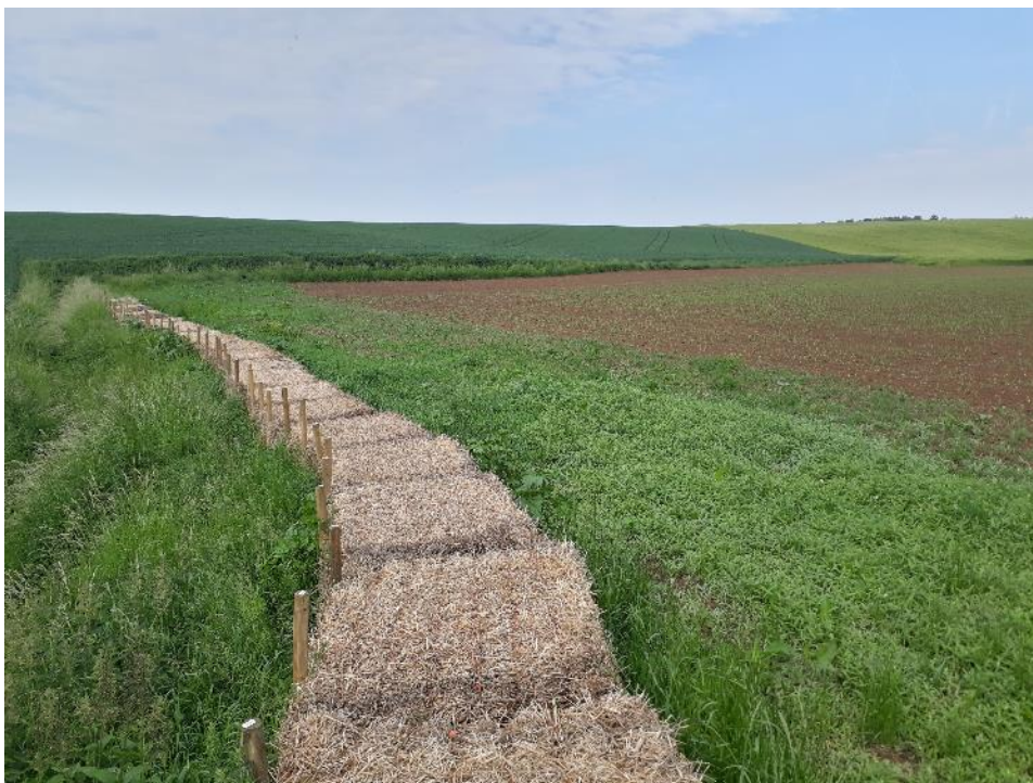
Figuur 8 Strobaleldam in het erosiegevoelige afstroomgebied van de Langegracht
