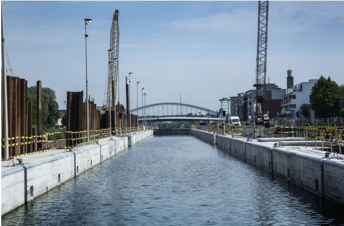
Figuur 10: Nieuwe sluis in Harelbeke (Bron: De Vlaamse Waterweg)
