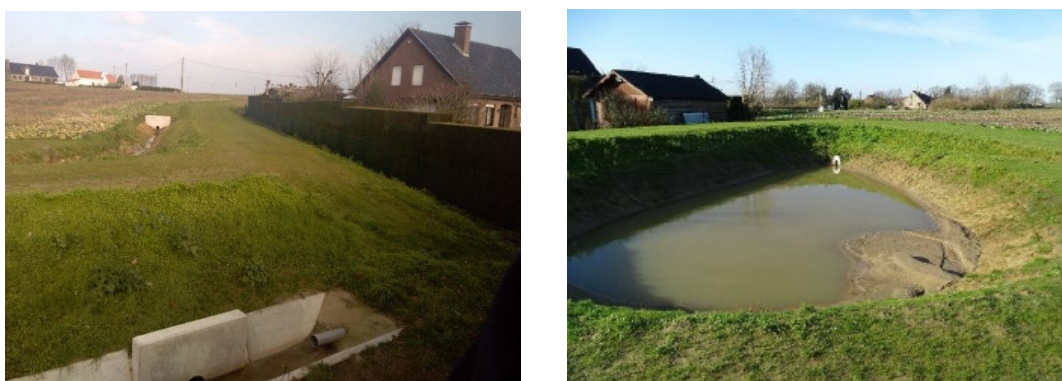
Figuur 7: gecontroleerde afvoer van afstromende water en ontdoen van sedimentvracht in Lichterveldsestraat Ardoorie (bron: Inagro)
