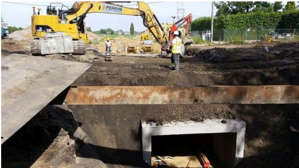
Figuur 5: aanleg koker bypass onder de spoorlijn te Heule (bron: VMM)
