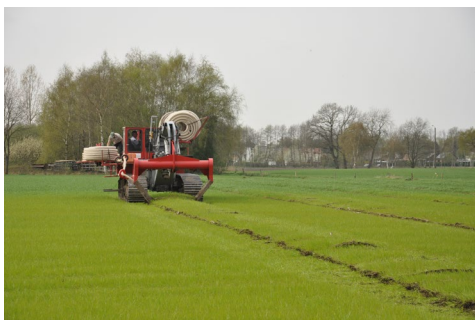
Figuur 18: Aanleg peilgestuurde drainage
