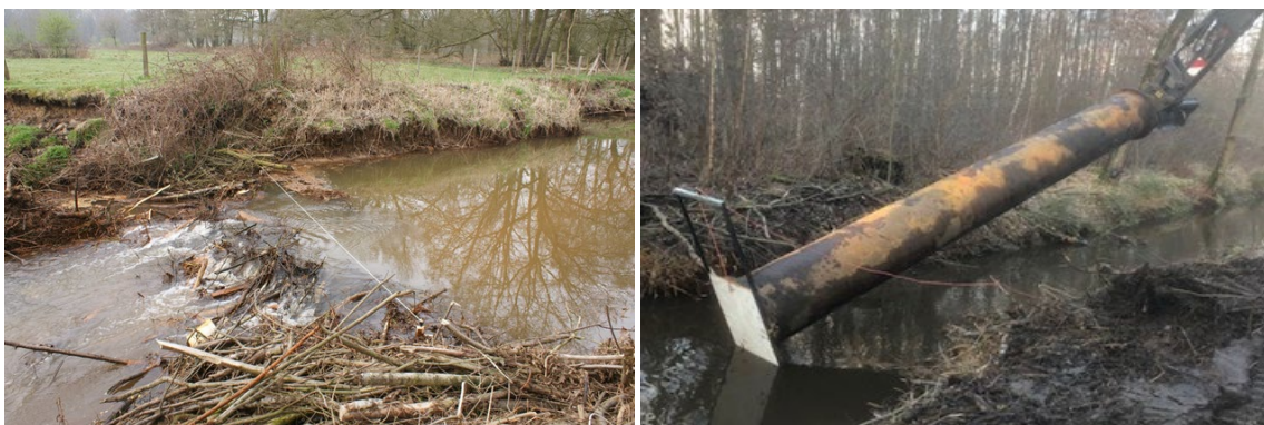
Figuur 13: Links: opstelling op de Itterbeek met stroomdraad boven de beverdam; rechts: installatie van de buis met moduleerbare klep op de Lozerbroekbeek
