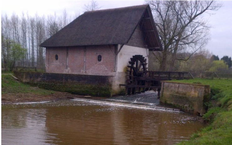
Figuur 11: De Laermolen vormt het laatste vismigratieknelpunt de Mark en verhindert momenteel migratie tussen het Merkske en de bovenlopen van de Mark.
