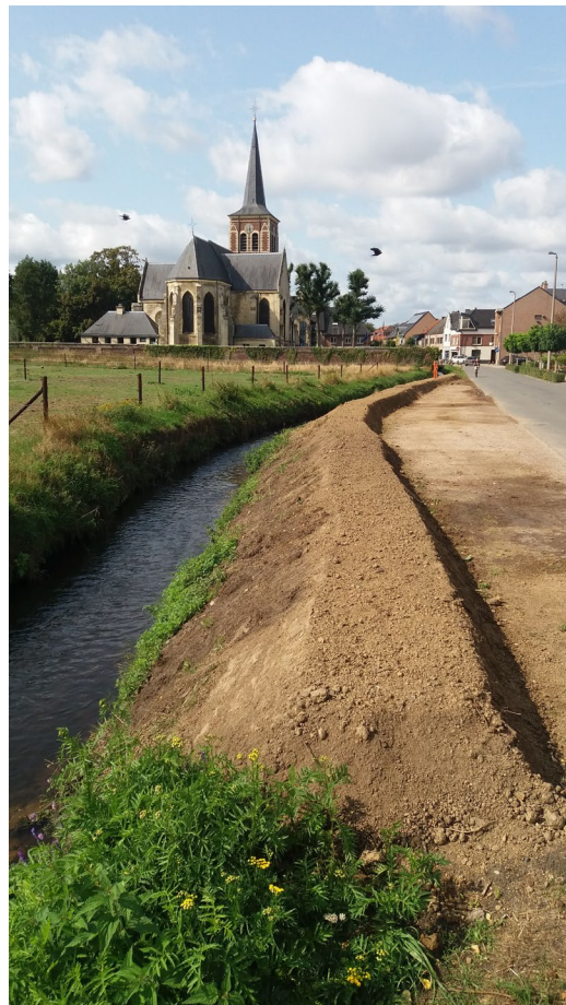
Figuur 10: Verschillende lokale dijkherstellingen en verhogingen werden uitgevoerd langs Bosbeek en Witbeek.
