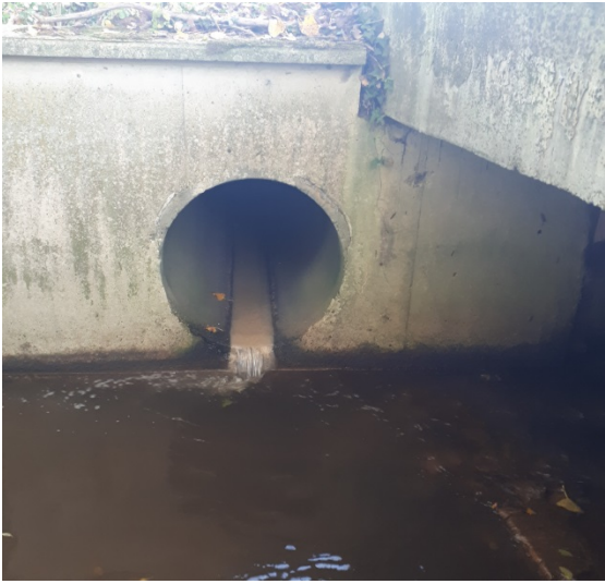
Figuur 16: Continue overstortwerking op de Abeek eind 2018 in Oudsbergen. Het was nodig om de hele pompput met overstortmuur onder de Baan naar Helchteren te vervangen.
