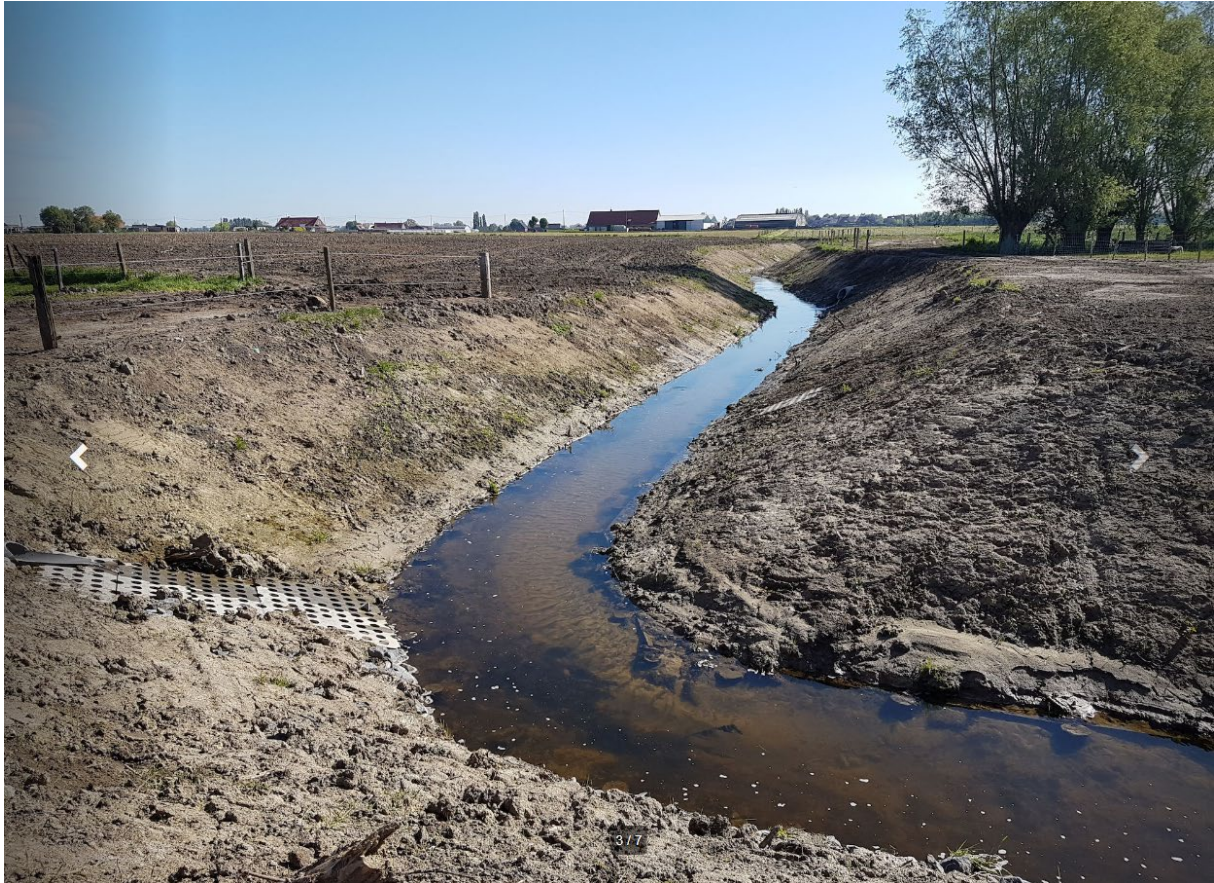
Figuur 4: heraanleg oevers Steenbeek (bron: provincie West-Vlaanderen)
