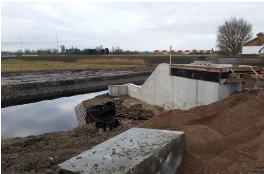
Figuur 5: Bouw van pompstation ter beveiliging van Snaaskerke (bron: provincie West-Vlaanderen)
