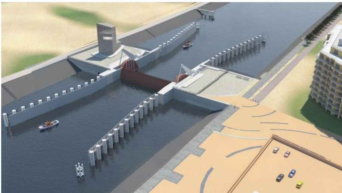
Figuur 7: Stormvloedkering in de havengeul te Nieuwpoort (bron: Afdeling Kust)
